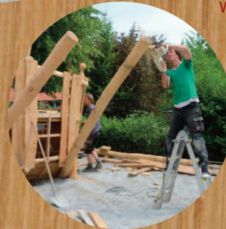
Unsere Spielanlagen werden aus beständigen, wildgewachsenen, splintfreien Robinien- und Eichenhölzern gefertigt. Robinie ist mit Widerstandsklasse I das beständigste europäische Holz überhaupt. Besonders wegen der hohen Härte und Elastizität eignet sich das Holz bestens für den Aussenbereich und den Kontakt mit dem Erdbreich. Alle Verschraubungen sind aus rostfreiem Edelstahl V2A.
